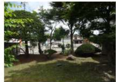
解体工事終了後の西庭
