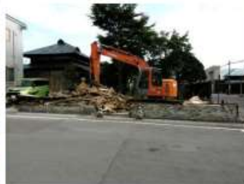
隣家の空き家解体工事
